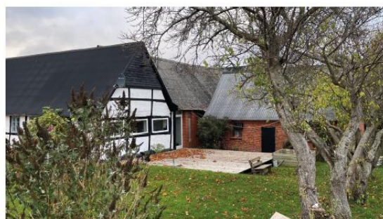
Beboelsesbygning, mellembygning, værksted og terrasse der nedrives - set fra sydøst
